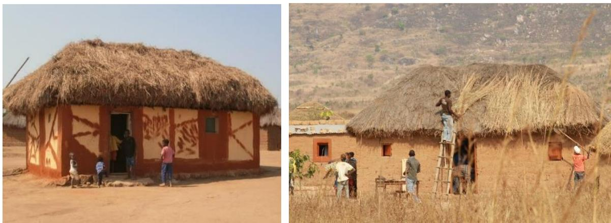
Figura 45 - Habitação tradicional e construção de uma cobertura em colmo na Província do Huambo. Fonte: Autor.
